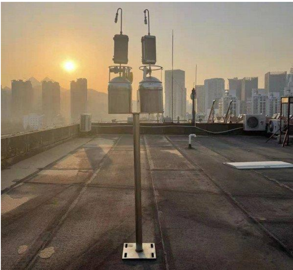
图 2 Nutech2701/优泰 S1000 现场安装图
