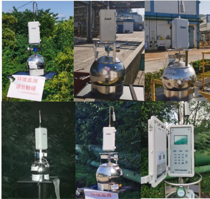
图 4 Nutech2703/优泰 S1600 现场安装图
